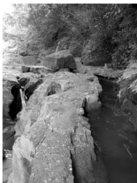
下田関吉の取水口と疏水起点付近
