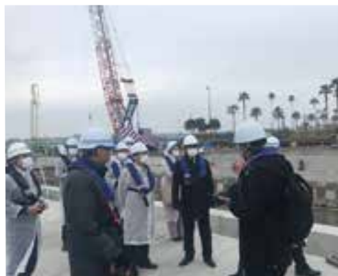
※建設現場視察の様子
