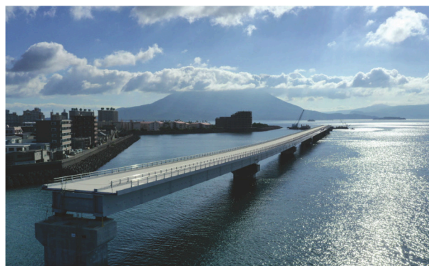
【写真】整備が進む鋼橋橋桁部 （臨港道路鴨池中央港区線）
